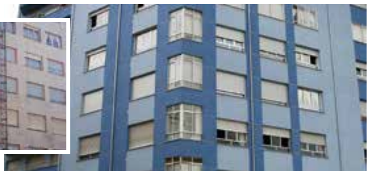
Rehabilitado con sistema Granocryl
