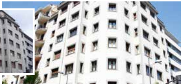
Rehabilitado con sistema Granocryl
