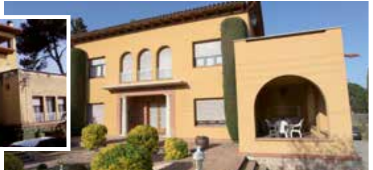
Rehabilitado con sistema Granocryl
