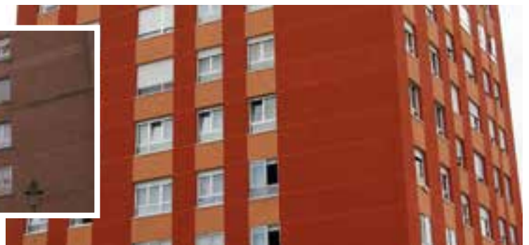
Rehabilitado con sistema Granocryl
